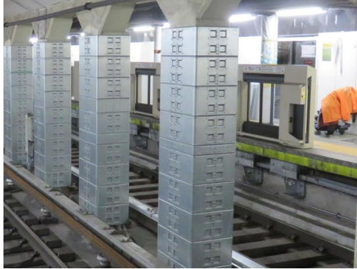
トンネル中柱補強
