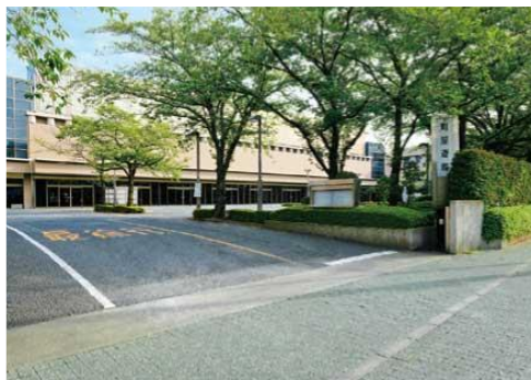
町屋斎場（荒川区）
