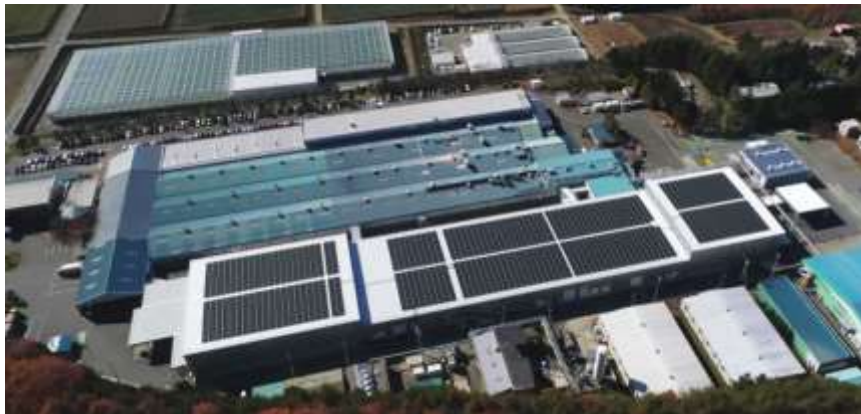
富士見工場の新棟に太陽光パネルを搭載
